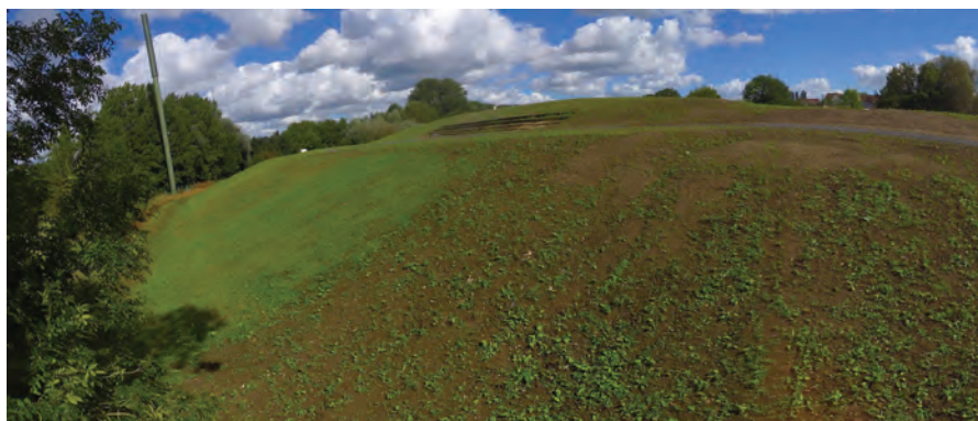
Juin 2024, ensemencement des coteaux et réalisation des gradins végétalisés
