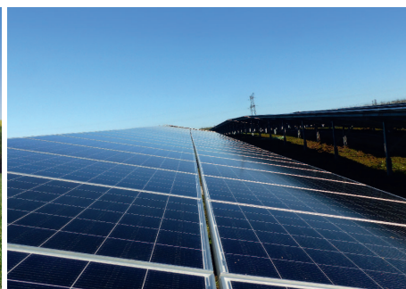
Développer l'énergie photovoltaïque Annet-sur-Marne (77).
